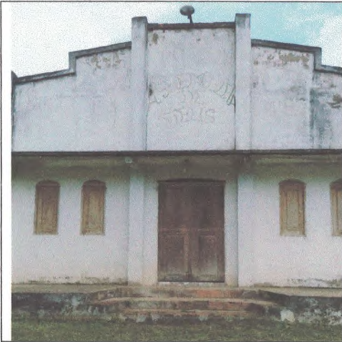
Vista Frontal (Fachada)
